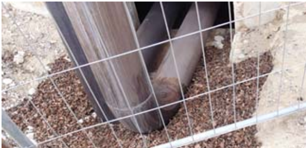
Heiße Abgasrohre und Brandschutz
